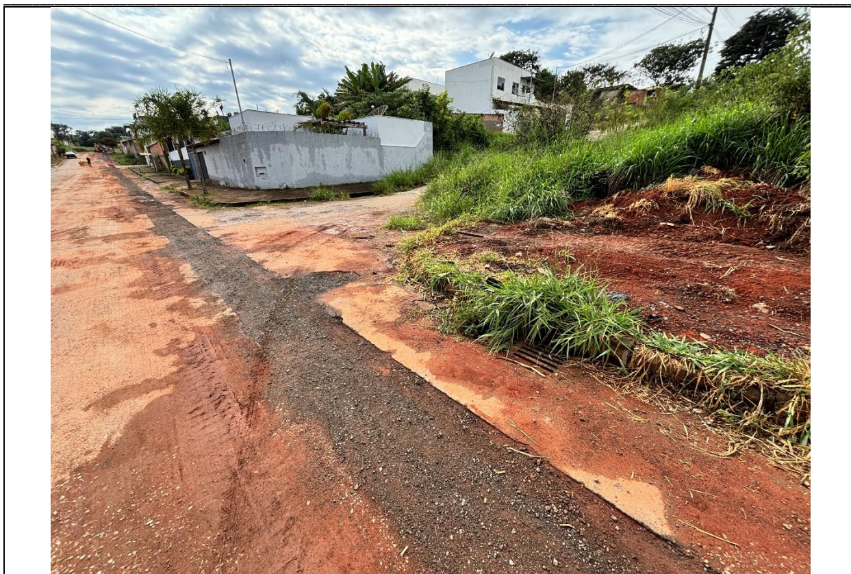
Imagem 02: Obra de extensão da rede municipal de abastecimento de água em curso durante vistoria. Fonte: Próprio autor.
