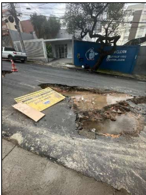
FOTO 1: 06/01/2025 – VAZAMENTO DE ESGOTO E EROSÃO
