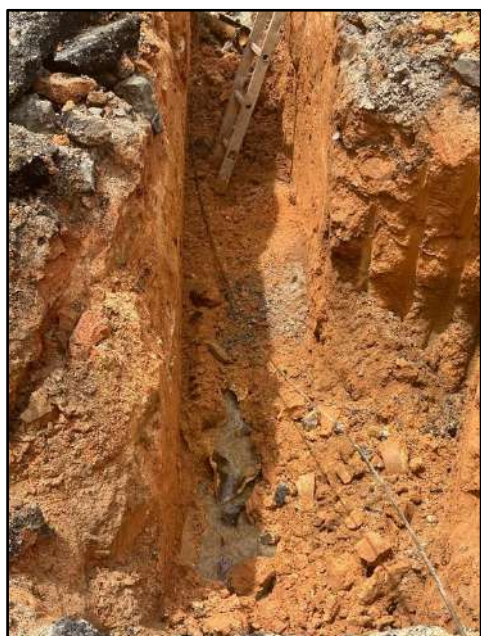
FOTO 4: REDE DE ESGOTO QUEBRADA COPASA
