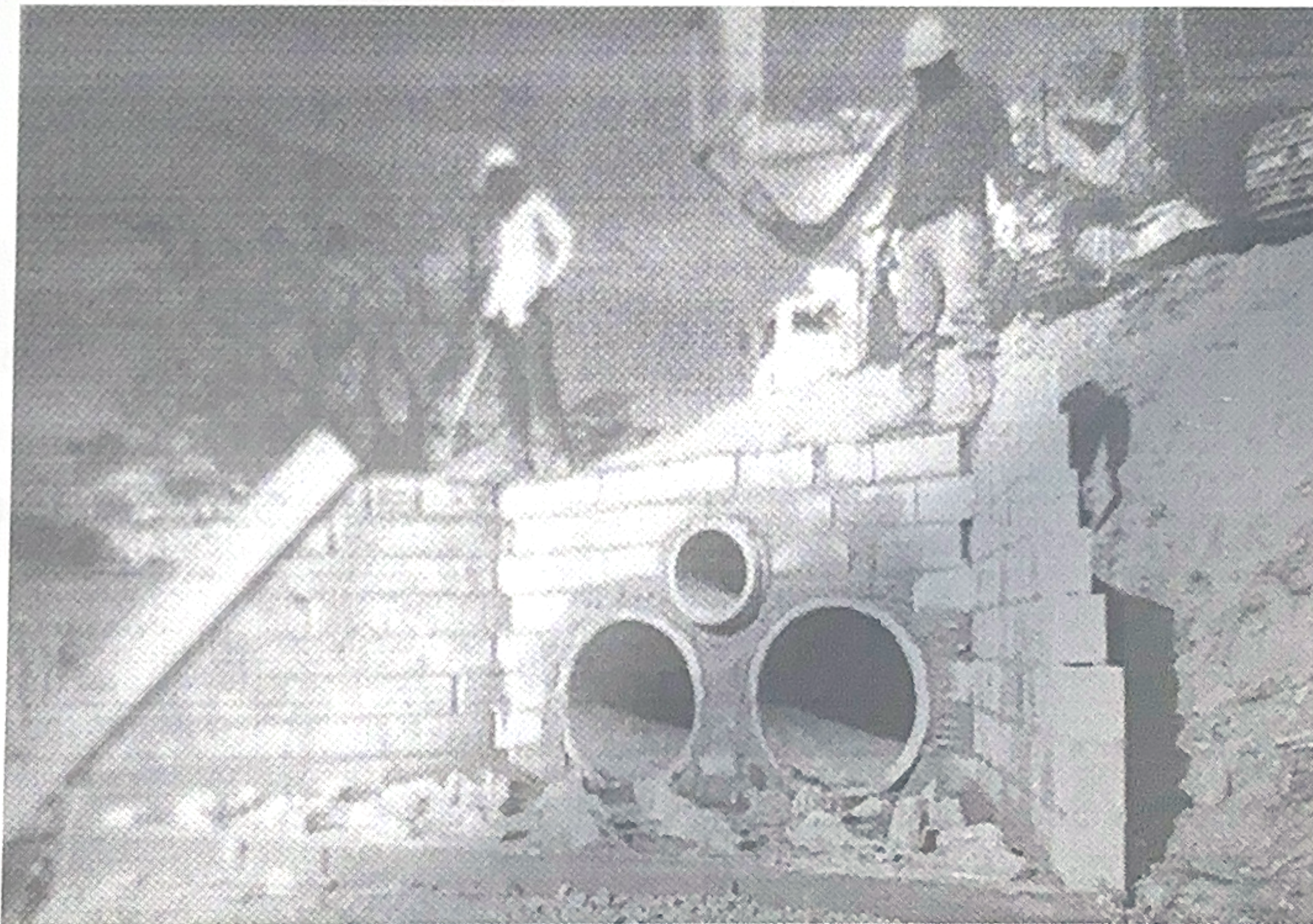
Foto – Ala de dissipação de energia em construção
