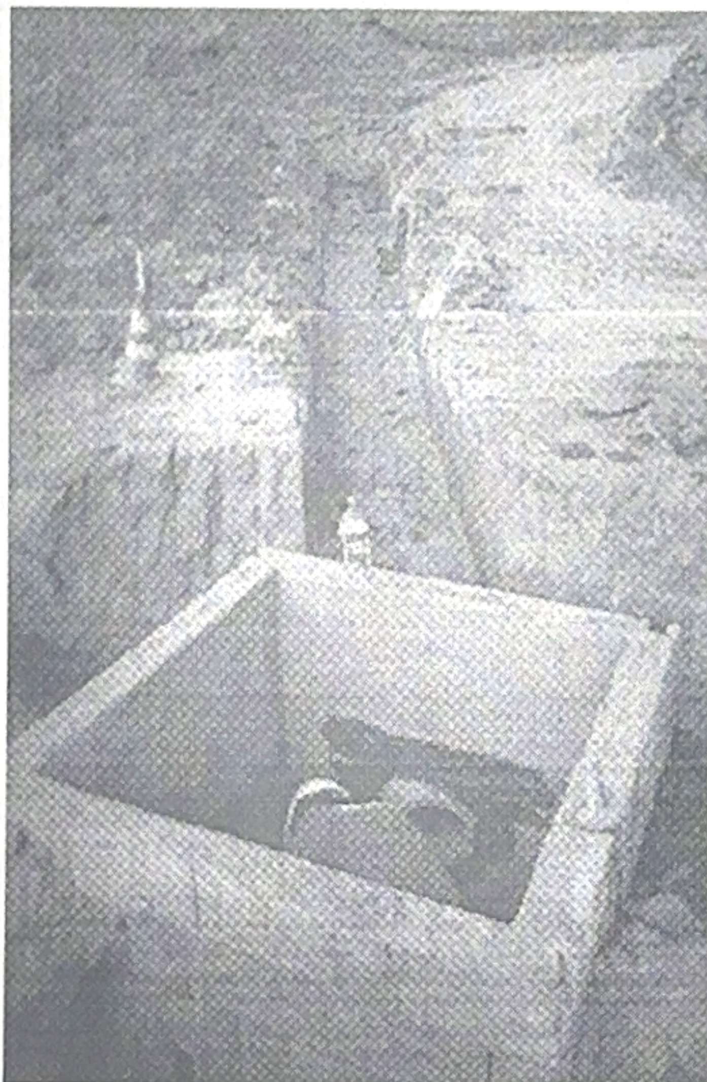
Foto – caixa de passagem em construção
