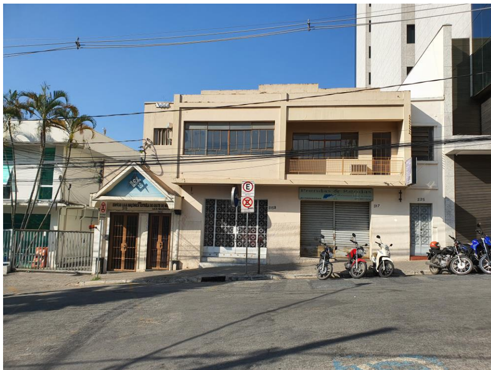
Figura 1 - Fachada do Imóvel
